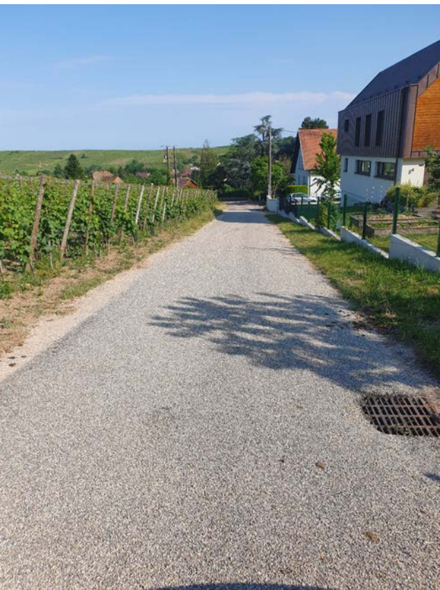
Réalisation du revêtement de deux portions de route blanche : rue du Kastelberg et rue des Bonnes Gens
