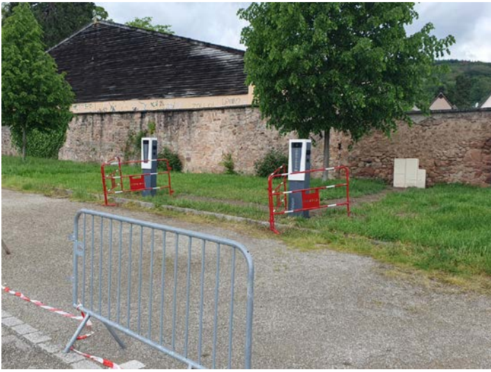
Mise en place de bornes pour voitures électriques au parking des remparts
